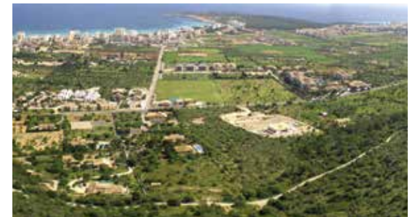
Vista aèria del periurbà de Cala Millor
