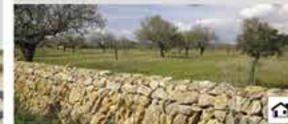
Un mur de pedra en sec
